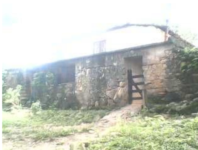
FIGURA 2 – Alicerces de pedra da fachada da antiga sede da fazenda do Rio Acima (São João del-Rei, MG)
