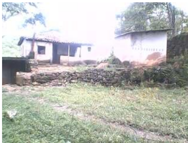
FIGURA 2 – Alicerces de pedra da fachada da antiga sede da fazenda do Rio Acima (São João del-Rei, MG)
