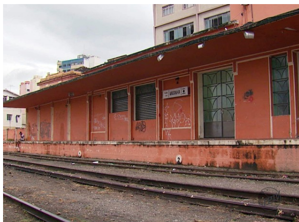
Figura 4 - Antes da requalificação
